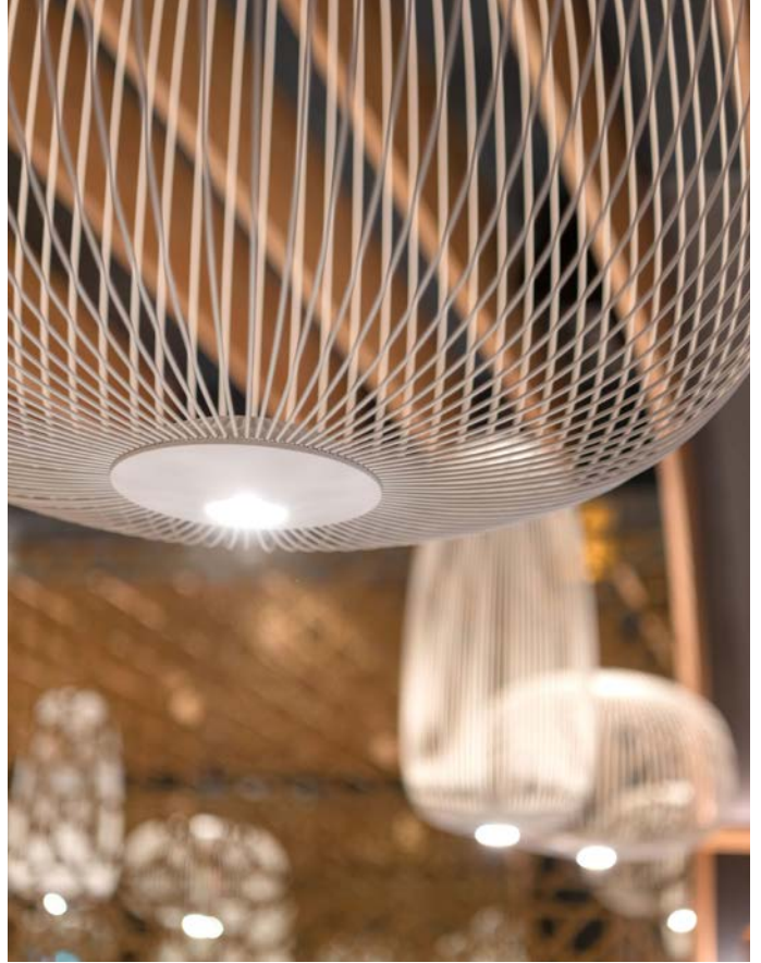
Abbildung 5: Die Stromversorgung der Leuchten ist in den Metallstreben integriert. Foto: Sabine Serrad
